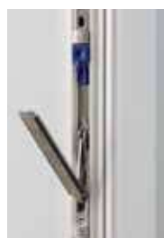
VERROUILLAGE DU VANTAIL SECONDAIRE
