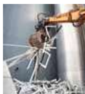
Collecte des anciennes menuiseries PVC
