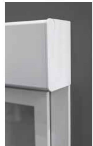
FINITION AVEC L'ALIGNEMENT DU COFFRE ET DE LA MENUISERIE
